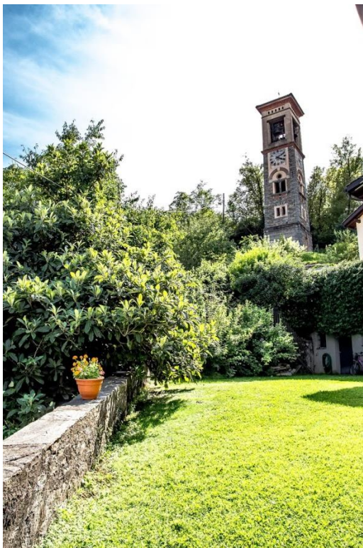
Il campanile della chiesa di S. Ambrogio.
